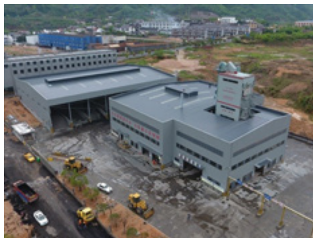
Рис. 4. Асфальтобетонный завод закрытого типа в Китае
